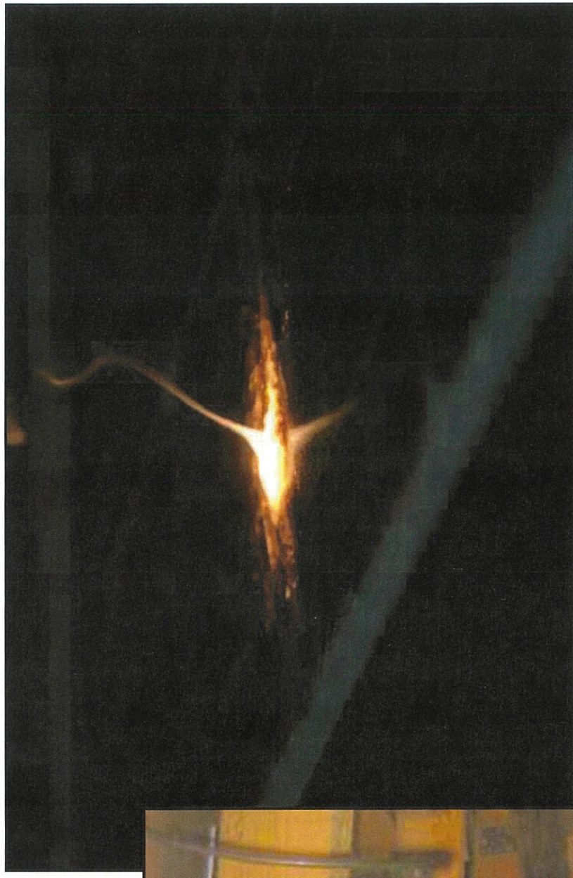
Arc dans un module PV
