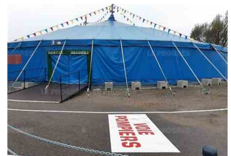
De nombreux travaux ont été réalisés par Les Puces du canal pour mettre aux normes la structure installée en 2017. Photo d'archives Progrès /Solén WACKENHEIM
